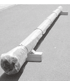
2 3 ゴムバンドでポリエチレンスリーブを管に固定します。
