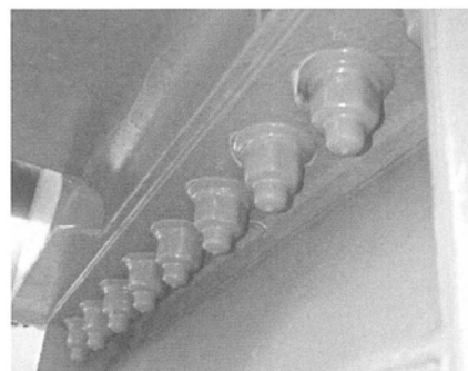
海岸部倉庫設備に取付
