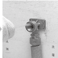
解氷パイプを配管内へ挿入し解氷作業開始
