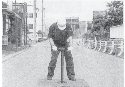
左右少しずつ回しながら調整する。
