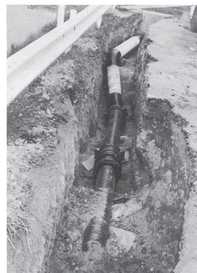
上水道配水管路
