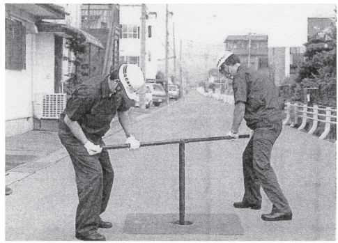
本体だけで回らない場合は、パイプを差し込み2人で回す。
