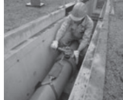
呼び径250、掘削幅60cm レバーホイスト1台で挿入可能
