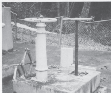
②ロットも撤去し、寸法をあわせ、SUS製中間ロットを施工します。
