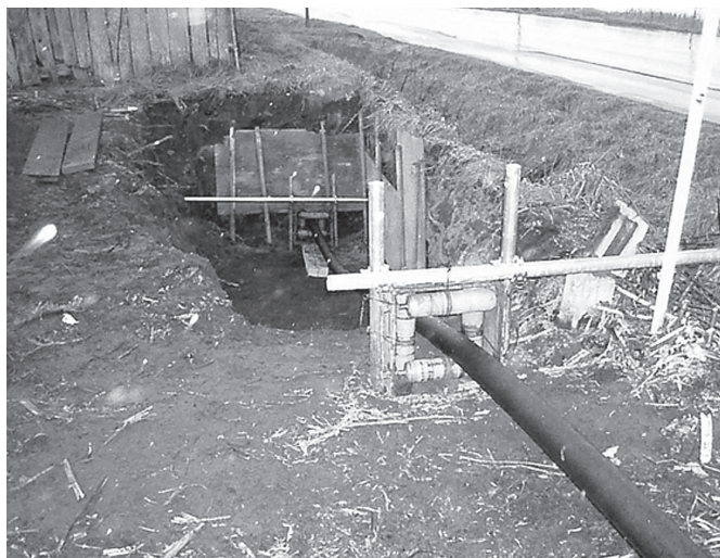
既設管へのパイプインパイプ工法
