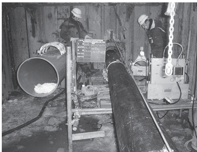
鉄道横断 鞘管推進工法
