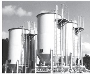
本装置は、従来の水処理におけるろ過があくまでも低濁度用システムであったものを、一歩進めて高負荷固液分離システム用として開発し、沈でん池の役割を果す機能を持っています。その最大の特長は、ろ過と同時に逆洗を行うことで閉塞をなくし、高負荷原水の処理を可能にした画期的なものです。
