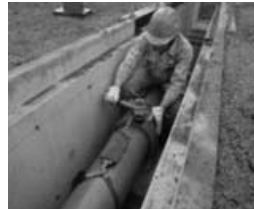
呼び径250、掘削幅60cm レバーホイス1台で挿入可能
