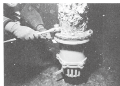
5. 新フート弁取付け
