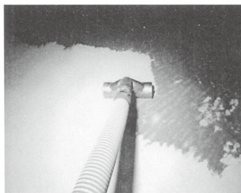
2.アクアエンジニアによる水中清掃作業
