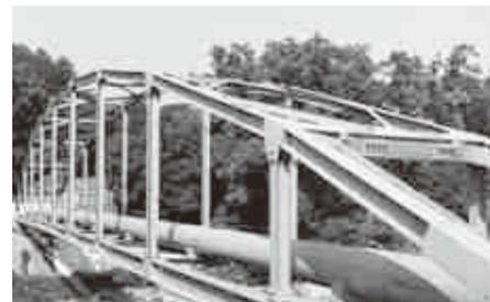
コーティング鋼管や、ステンレス鋼管を用いた水管橋は、耐食・耐候性に優れ、高い信頼性を持ちます。設計から加工、組立・施工までの一貫体制でニーズに対応します。
