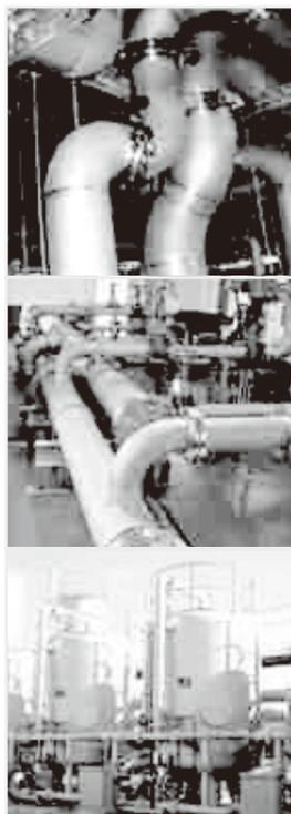
配管材料の腐食問題に対応したステンレス鋼管は、軽量のため運搬・施工が容易。プレファブ化した製品の提供により、溶接等の作業工程の簡略化、コストの低減も図れます。
