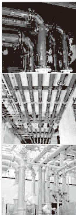
マルチプルな特性で、水の高度なクリーン化を実現したLP（硬質塩化ビニルライニング鋼管）。
