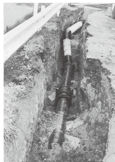
上水道配水管路
