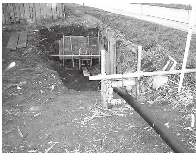
既設管へのパイプインパイプ工法
