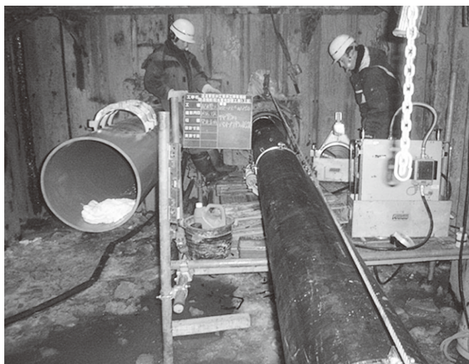
鉄道横断 鞘管推進工法
