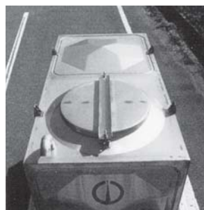
マンホール部分
