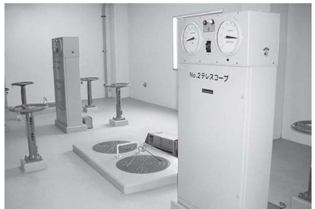
急速濾過調節機（テレスコープ型）
