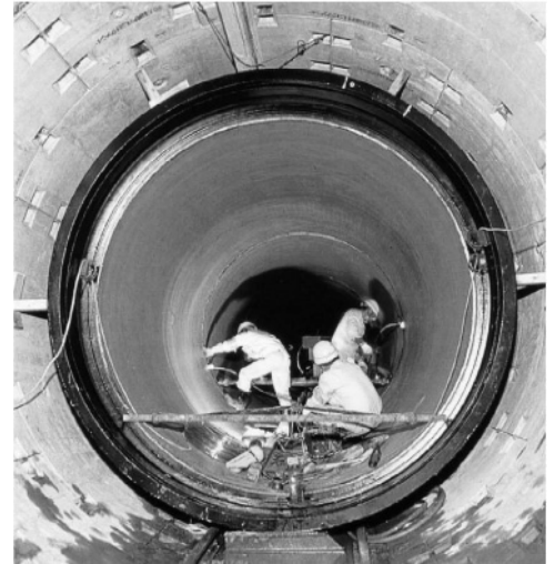
U形（内面継手） 呼び径700mm～2600mm
