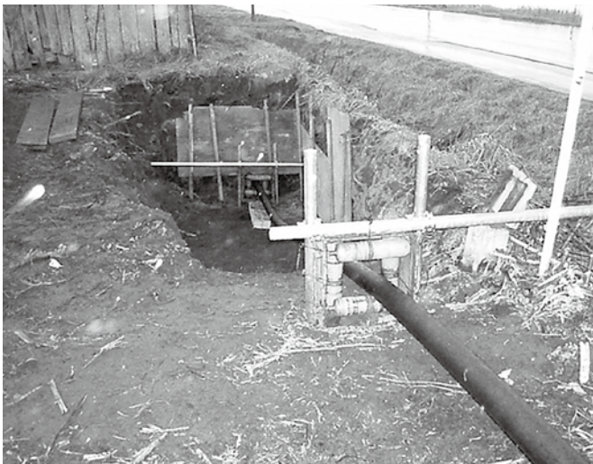
既設管へのパイプインパイプ工法
