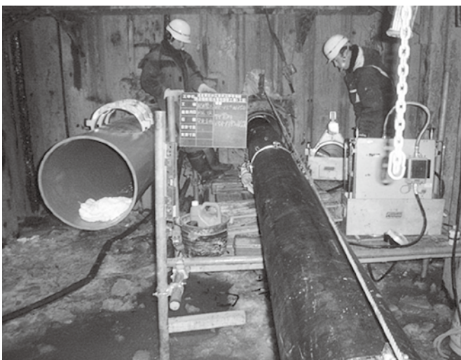
鉄道横断 鞘管推進工法
