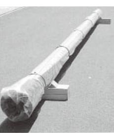
2 ゴムバンドでポリエチレンスリーブを管に固定します。
