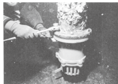
5.新フート弁取付け
