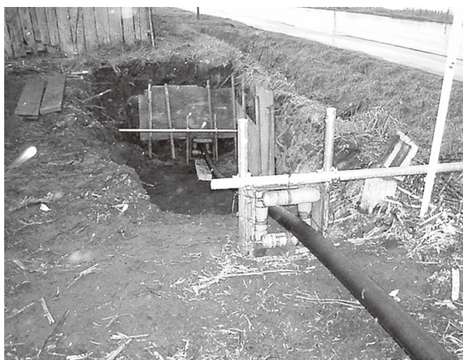
既設管へのパイプインパイプ工法
