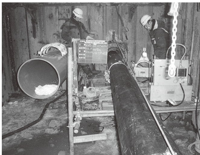
鉄道横断 鞘管推進工法
