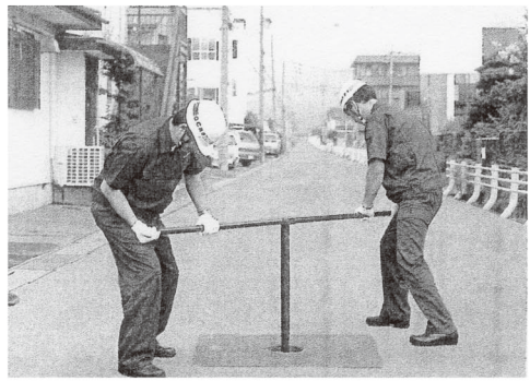
本体だけで回らない場合は、パイプを差し込み2人で回す。
