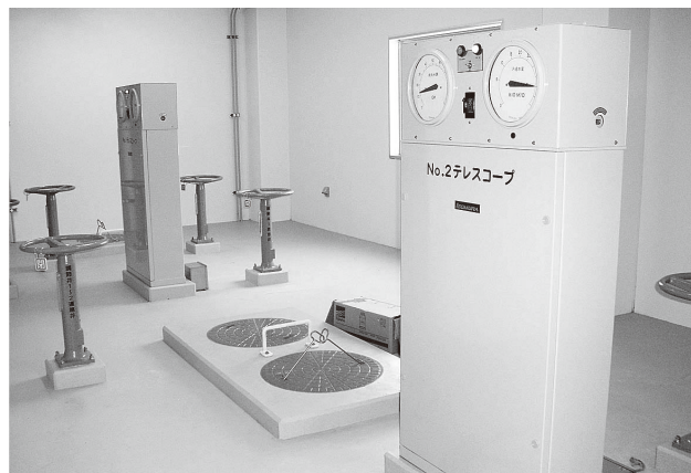
急速濾過調節機（テレスコープ型）
