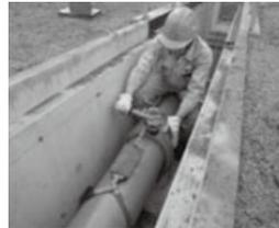
呼び径250、掘削幅60cm
