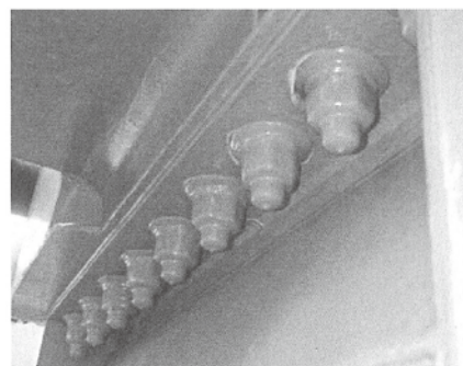
海岸部倉庫設備に取付
