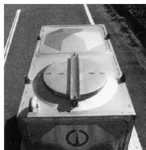
マンホール部分
