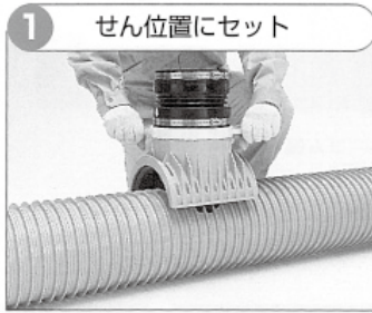
クイックブランチをせん孔位置に合わせてセットします。
