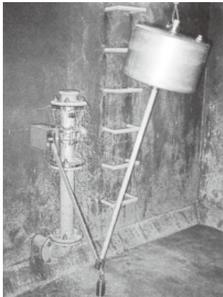
▲ (B-2) 型流入方向下から上設置例 (オールステンレス製)
