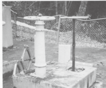
②ロットも撤去し、寸法をあわせ、SUS製中間ロットを施工します。
