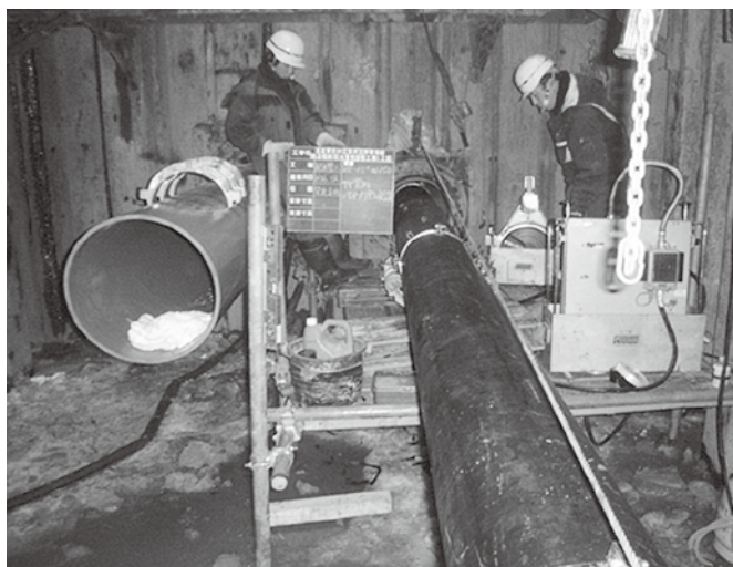
鉄道横断 鞘管推進工法
