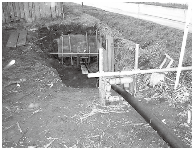
既設管へのパイプインパイプ工法
