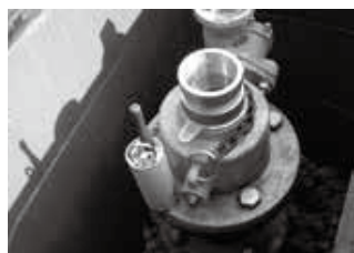
消火栓へのロガー設置
