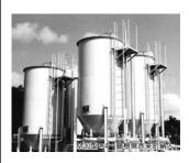
本装置は、従来の水処理におけるろ過 があくまでも低濁度用システムであ ったものを、一歩進めて高負荷固液 分離システム用として開発し、沈でん 池の役割を果す機能を持っています。 その最大の特長は、ろ過と同時に逆洗 を行うことで閉塞をなくし、高負荷 原水の処理を可能にした画期的なも のです。
